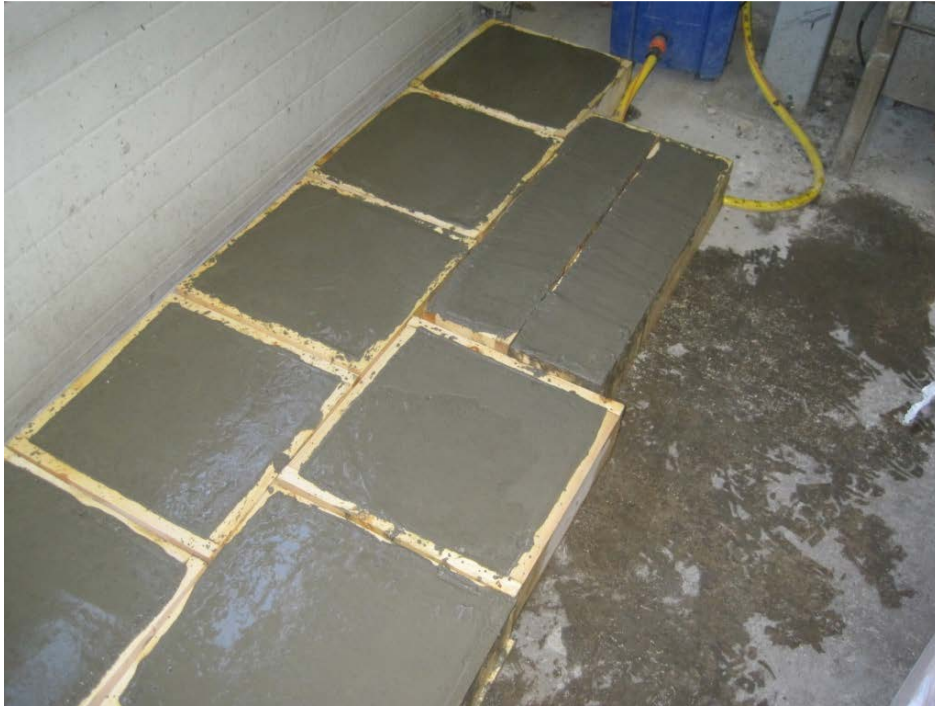
Figur 3. Balk- och plattformar precis efter gjutning.
