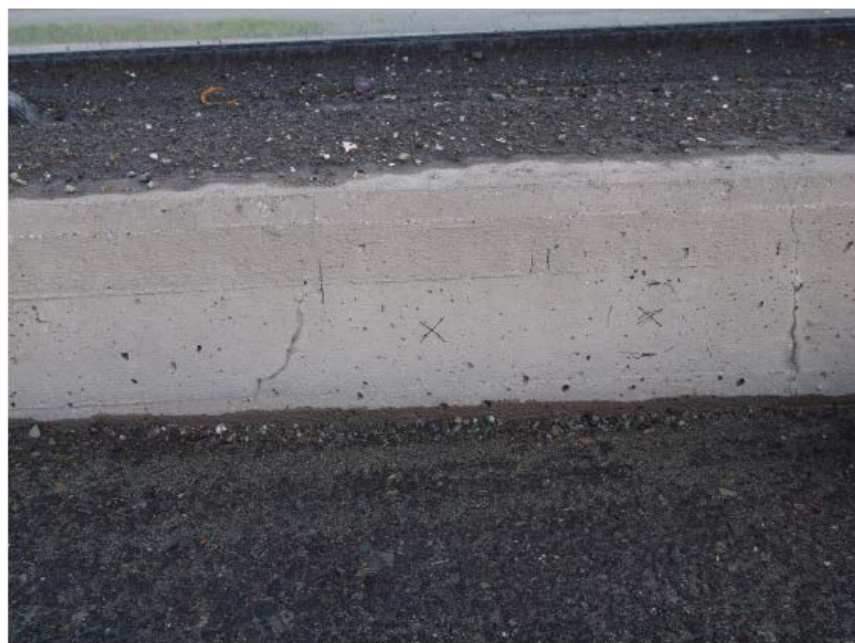
Rosvollbrua: Prøveuttak oppmerking mellom armeringsjern på kantdrager
