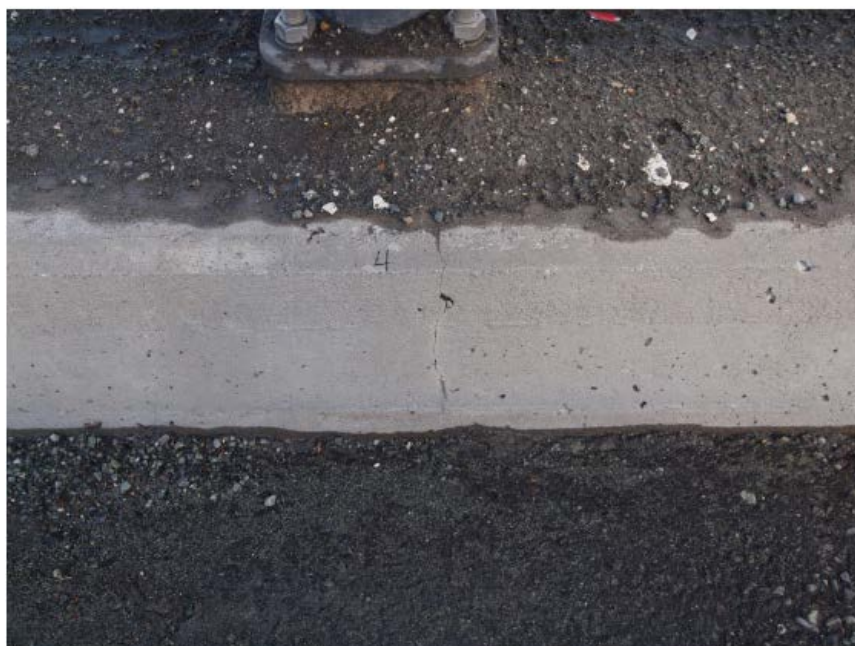
Rosvollbrua: Sprekk ved stolpe 4
