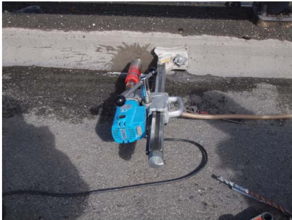
Rosvollbrua: Utboring av betongkjerner
