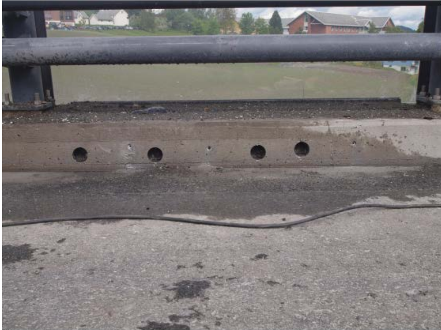
Rosvollbrua: Utborede betongkjerne mellom stolpe 4 – 5.
